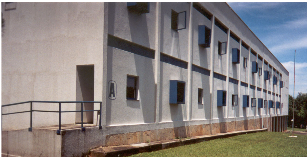
Fotografia 4.43 – Fachada norte das Escolas de Engenharia Civil e Engenharia Elétrica (EEC/EEE) mostrando janelas com e sem sistemas quebra-sóis.
