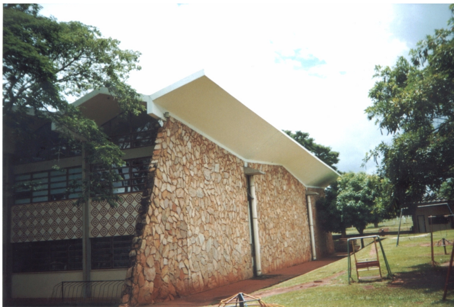
Fotografia 4.41 – Fachada leste/sudeste, igual à fachada oeste/noroeste, do CEPAE, mostrando revestimento de pedra e beirais avantajados.
